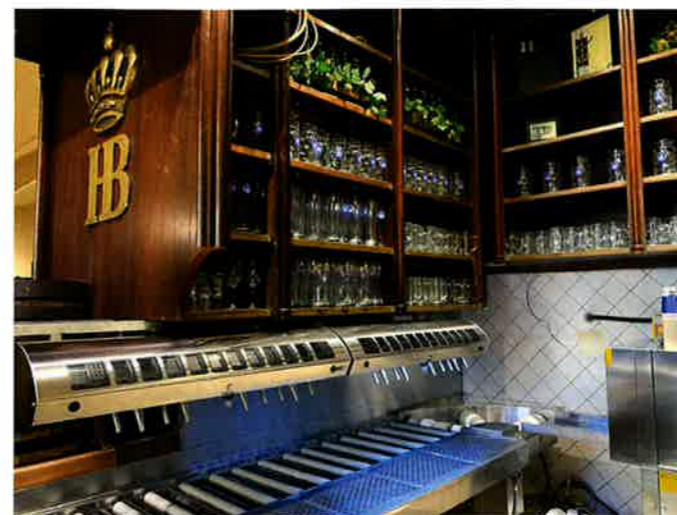
Großbetrieb: Die 14 Viso-Schankköpfe mit 40 Bierhähnen im Hofbräuhaus lassen sich mit über 250 Kellnerschlüsseln bedienen
