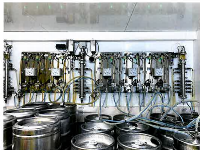
3 Schankköpfe, 7 Keg-Robots, 3 Schnaps pistolen, ein Ringsystem und die Integration von Libra-Wiege laden sorgen im Umbrella für reibungslose Abläufe
